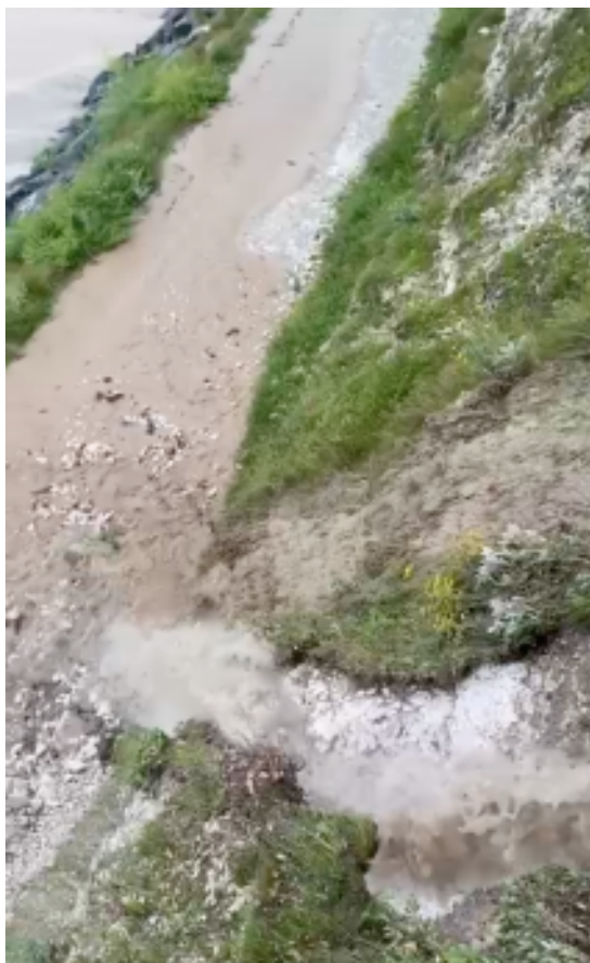
Chutes d'eau sous la casquette, érodant la falaise au-dessus de la digue 83
