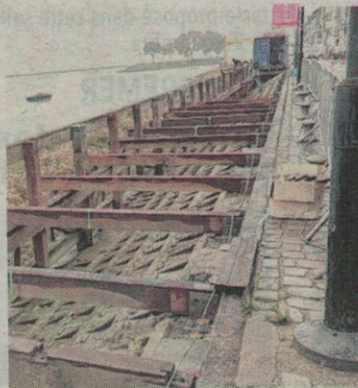
La dernière partie de l'estacade sera complètement rénovée d'ici avril, sauf météo contrariante.
