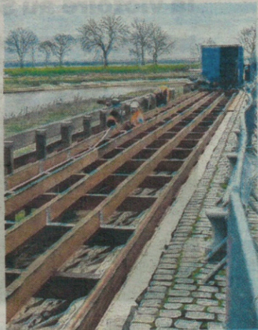
Un chantier de rénovation totale a été lancé en 2021/2022.
