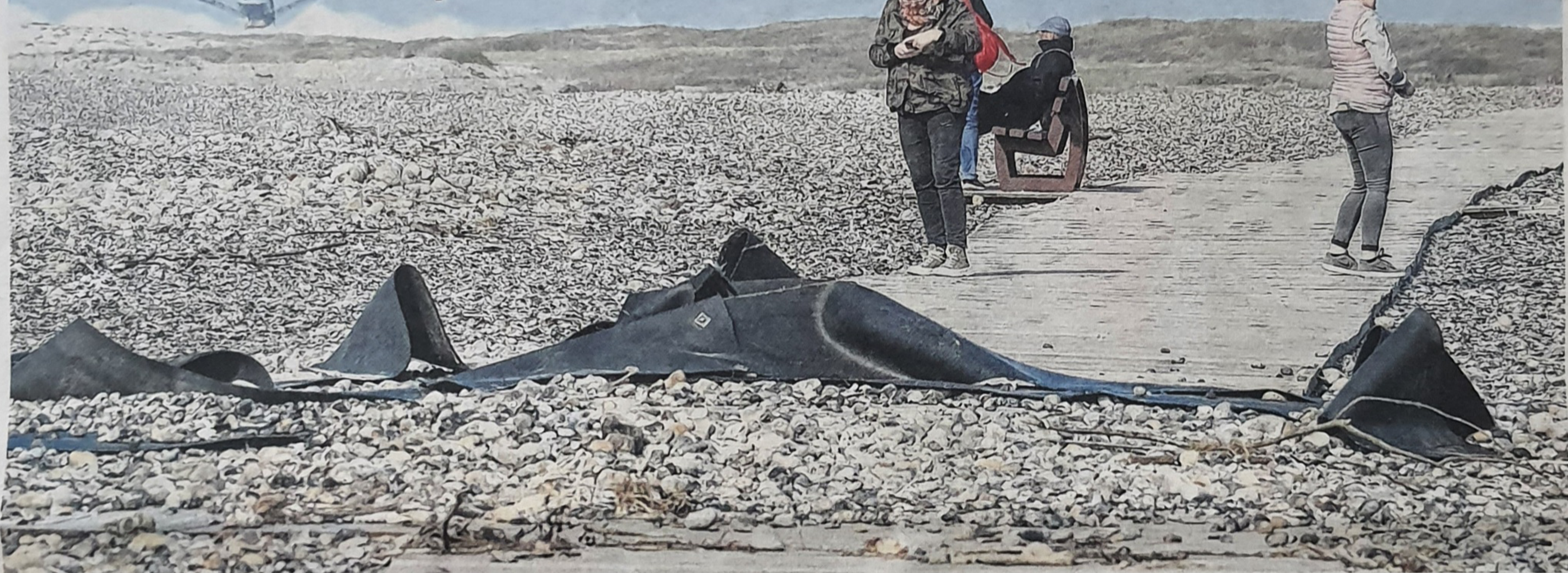
La tempête Pierrick a fait des dégâts sur le chemin des planches de la plage de Cayeux-sur-Mer. Photos Fred Haslin
