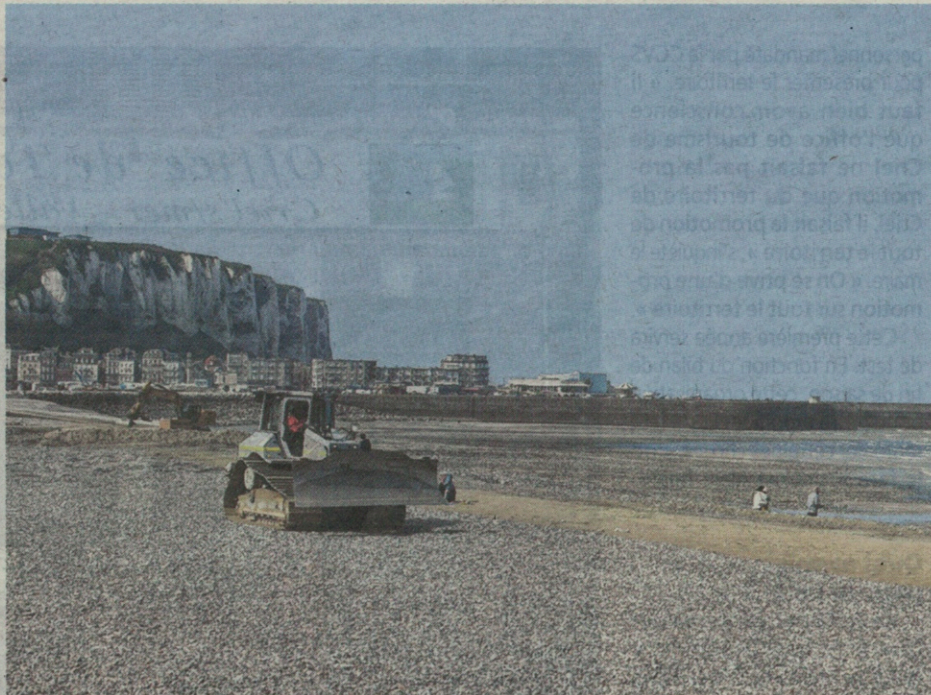
Les opérations ont pour but de recharger la plage en galets pour maintenir une protection efficace contre la mer. Photo d'archives de 2023.
