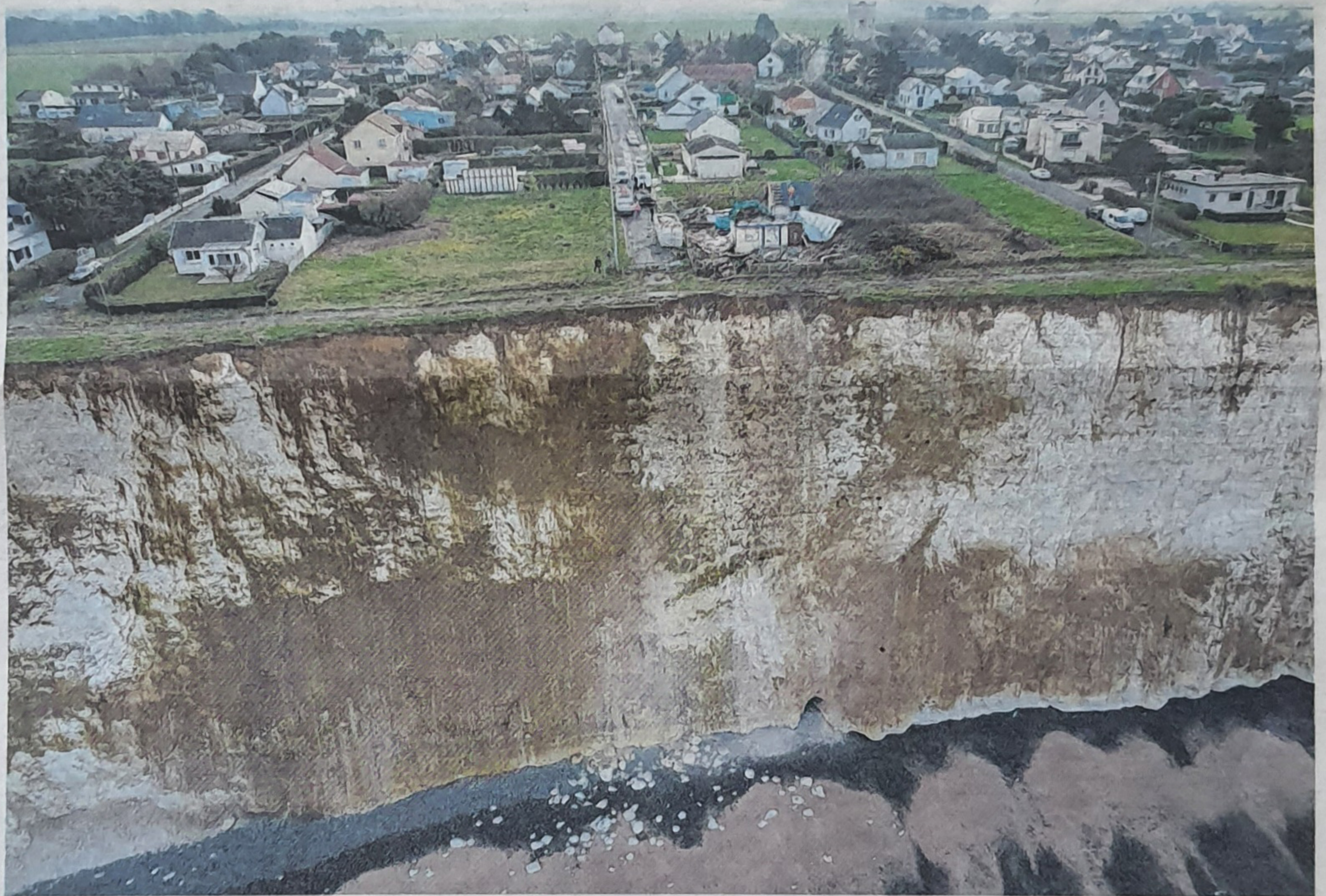
Démolition d'une maison en bord de falaise à Criel-sur-Mer en vue aérienne par drone. Photo d'archives Fred HASLIN
